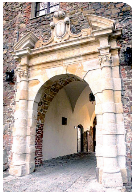
Brama przejazdowa budynku bramnego z portalem po remoncie
